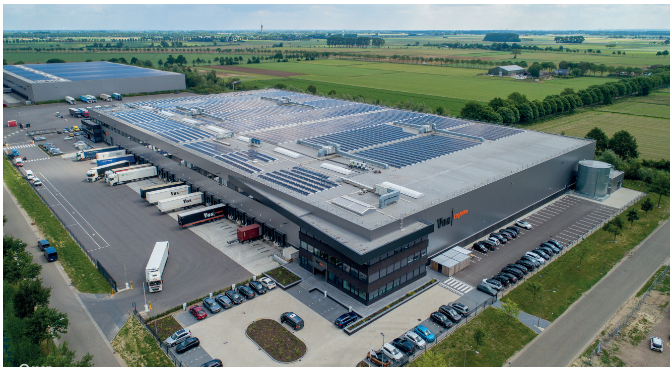
Photovoltaik-Module auf dem Dach des Logistikgebäudes von GLP im niederländischen Oss. Foto: GLP PF Germany Management GmbH
