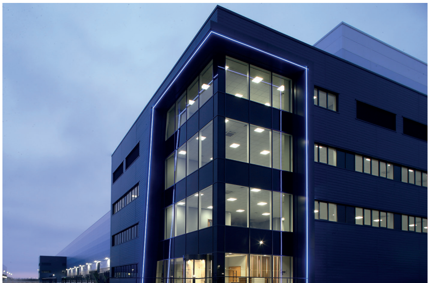
Das Logistikgebäude Magnitude 314 in Milton-Keynes, England, wurde mit sehr wenig CO 2 -Emissionen gebaut. Foto: GLP PF Germany Management GmbH
